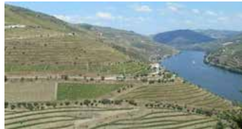
Figura 4 – Exemplicação da ausência de IEs, com inexistência de vegetação entre taludes. Foto dos autores, 2018.
